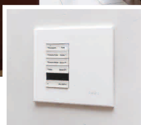
No espaço gourmet, com TV na parede e caixas acústicas ocultas sob o forro de gesso, um dos painéis que permitem controlar as luzes.
